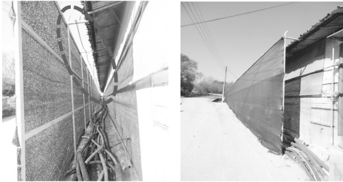
◆ 방풍벽 및 분무노즐 설치
