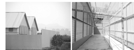
◆ 축사 외부 방풍벽 설치 현황
