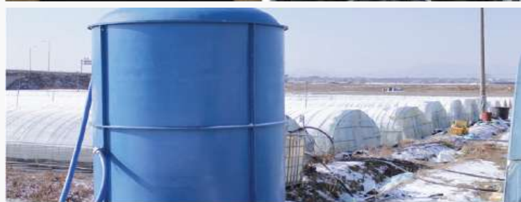
시설재배단지 설치 액비탱크(15톤)
