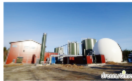
<가축분뇨 바이오가스 설비>
